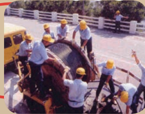
本澳第一條光纖電纜投入服務 Connection of the first optical fiber cable in Macau Ligação do primeiro cabo de fibra óptica em Macau
